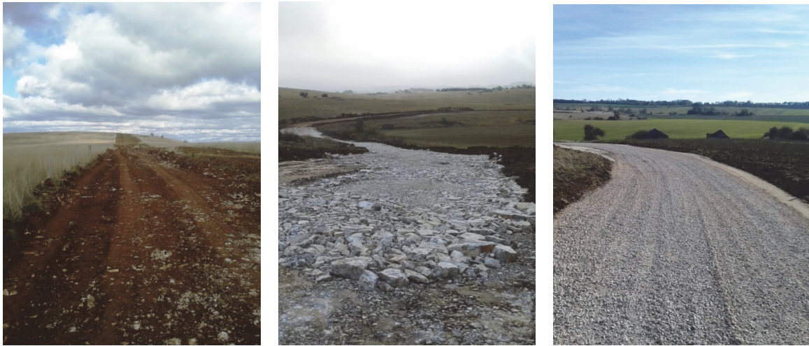
Opération de décapage ; mise en place de la couche de fond de forme ; mise en place de la couche de finition Photos de gauche à droite (Source : RES – Parc éolien de La Baume)
